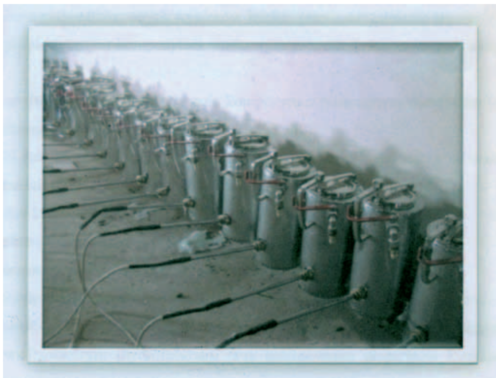
Rys. 2. Realizacja wtórnej izolacji poziomej metodą iniekcji termohermetycznej
